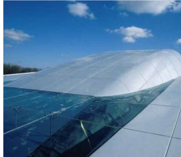
FIG. 7.8 Productie en montage van 3D vervormde aluminium panelen op holle mal explosief geperst Hoofddorp, zie 7.1.
