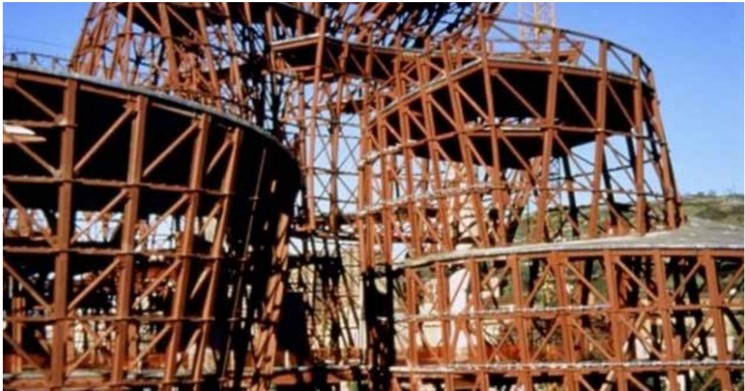
FIG. 7.10 Bouwfoto van de hoofddraagconstructie van het Guggenheim Museum in Bilbao, in Catia uitgewerkt, maar nog op een simpele en grofstoffelijke manier geconstrueerd.
