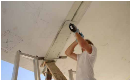
FIG. 7.16 Assemblage van segmenten tot één schaalvorm in Tel Aviv
