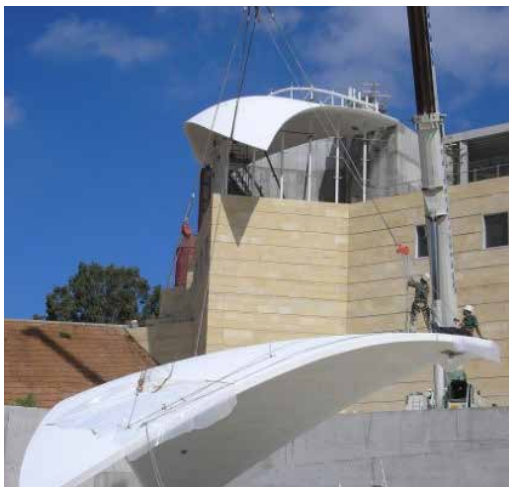
FIG. 7.17 Hijsen van de complete schaal in Tel Aviv
