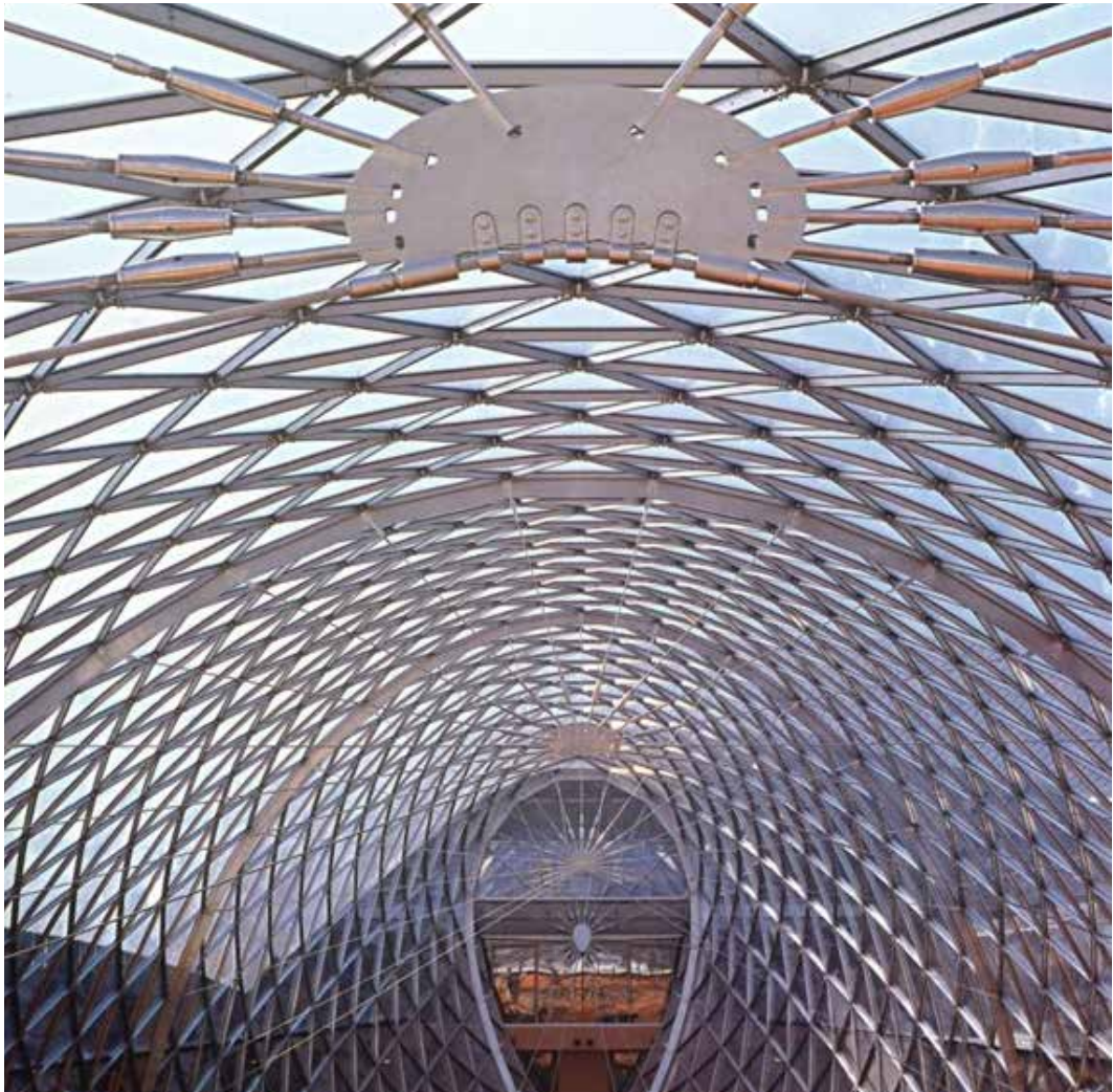
FIG. 7.12 Glazen dak DG Bank met staven, knooppunten, glaspanelen en verstijvingen, Frank Gehry.
